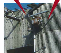
高圧変圧器 高圧コンデンサー
