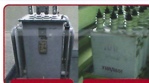
高圧変圧器 高圧コンデンサー
