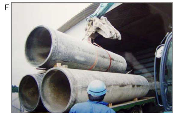
F 青石綿含有の使用済み水道管の現在の搬出風景。重量物ですので扱いが多少は手荒になることもあります。以前は現場で粉々に砕いて埋めており、その際に粉じんが舞ったと考えられます。
